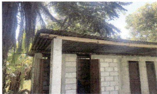
Foto 5: Estructura de madera en malas condiciones.
