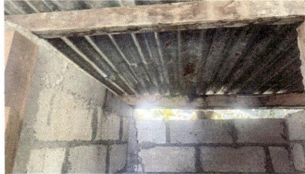
Foto 2: Techo de lamina y estructura d madera en malas condiciones.
